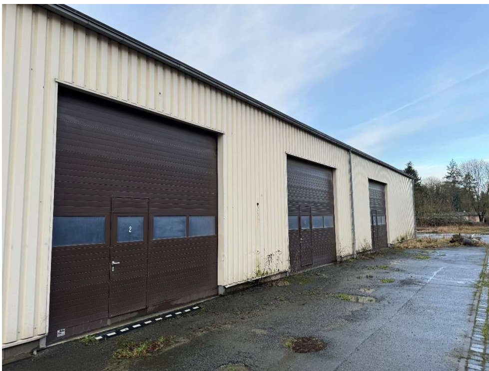
Foto 4: Vorhandene Gebäude, größere Halle
