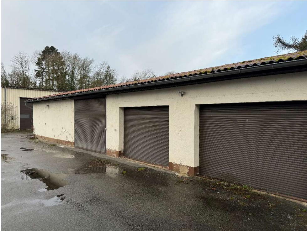
Foto 3: Vorhandene Gebäude, Beispiel
