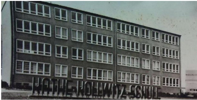
Abbildung 114: Gebäude Käthe-Kollwitz-Schule vor Modernisierung/Sanierung 124
