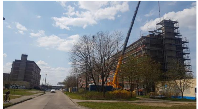
Abbildung 95: Lindenallee 3-27 während des Rückbaus 99
