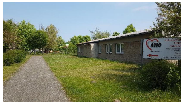
Abbildung 107: Unsanierteres Sozialgebäude südlich der Kindertagesstätte "Max und Moritz" 114
