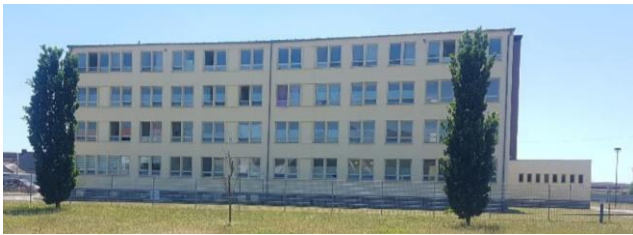
Abbildung 115: Gebäude Käthe-Kollwitz-Schule nach Modernisierung/Sanierung 2016 125
