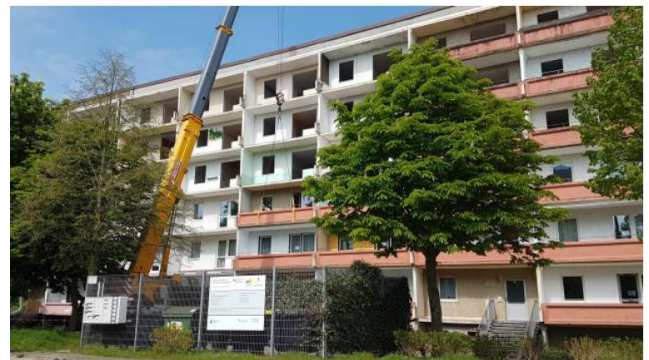
Abbildung 94: Lindenallee 13-19 während des Rückbaus 98
