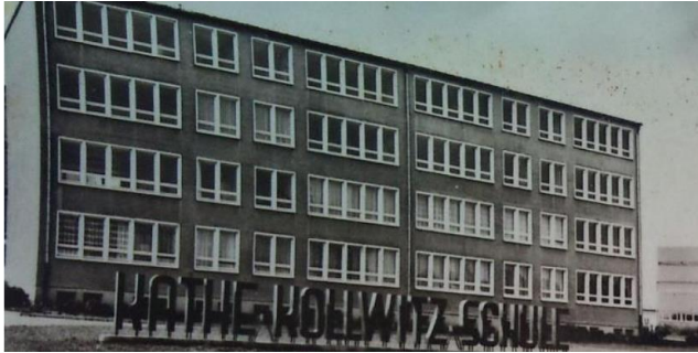
Abbildung 114: Gebäude Käthe-Kollwitz-Schule vor Modernisierung/Sanierung 124
