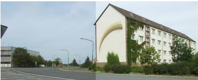
Abbildung 113: Uelzener Straße 92-98 vor und nach dem Abriss 122
