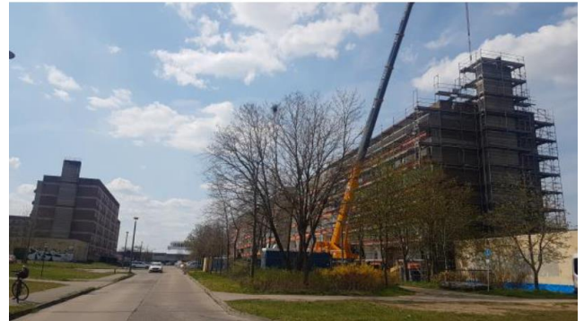
Abbildung 95: Lindenallee 3-27 während des Rückbaus 99
