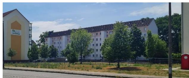
Abbildung 103: Begrünte Abbruchfläche Ernst-Thälmann-Straße 20-26 110
