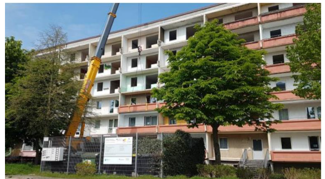
Abbildung 94: Lindenallee 13-19 während des Rückbaus 98
