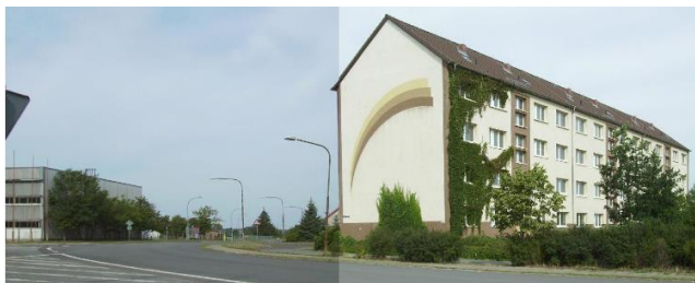
Abbildung 113: Uelzener Straße 92-98 vor und nach dem Abriss 122
