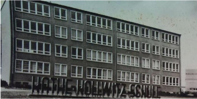
Abbildung 114: Gebäude Käthe-Kollwitz-Schule vor Modernisierung/Sanierung 124
