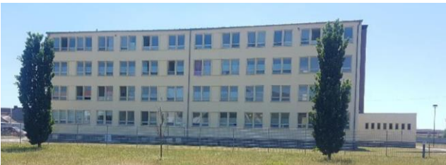
Abbildung 115: Gebäude Käthe-Kollwitz-Schule nach Modernisierung/Sanierung 2016 125
