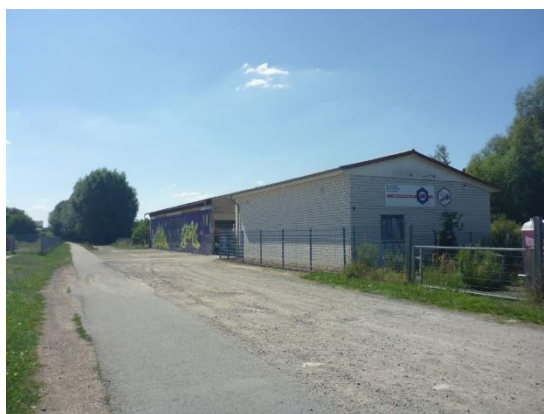
Abb. 6 Blick auf den Nachtweidenweg und die beiden Gebäude im Änderungsbereich.
