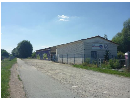
Abb. 5 Blick auf den Nachtweidenweg und die beiden Gebäude im Änderungsbereich.
