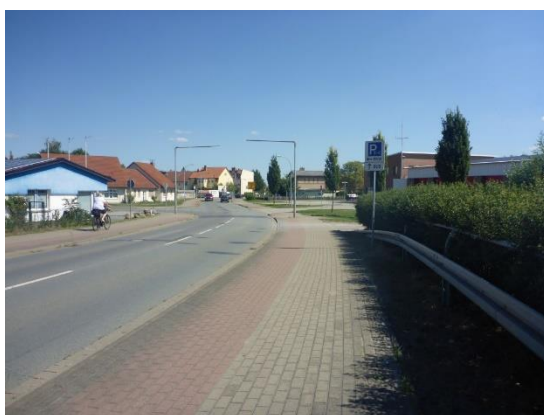
Abb. 11 Blick auf die Brückenstraße und die nordöstlich an den Änderungsbereich angrenzende Bebauung.
