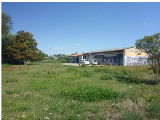
Abb. 6 Blick von Süden auf die Bestandsgebäude.
